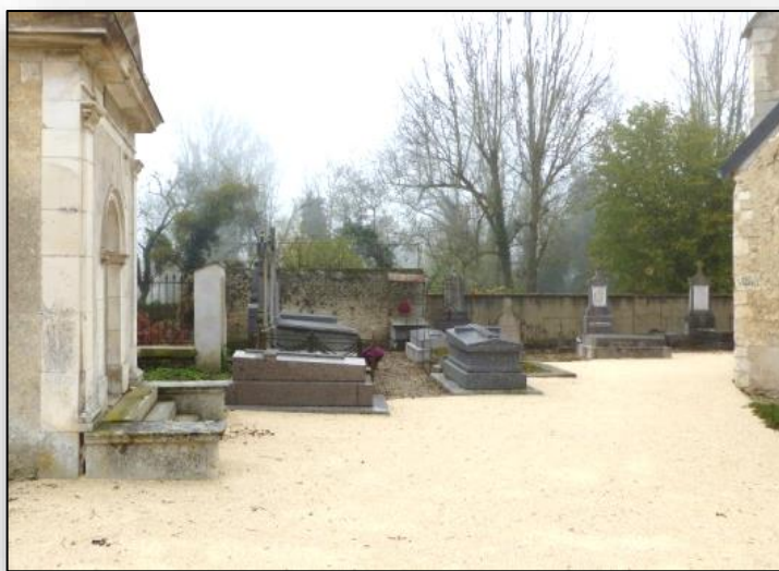
SOL APRES TRAVAUX
